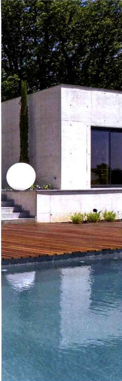
Lames de terrasse protégées et teintes par un saturateur. ©Vivre en Bois (Nivolas-Vermelle)
