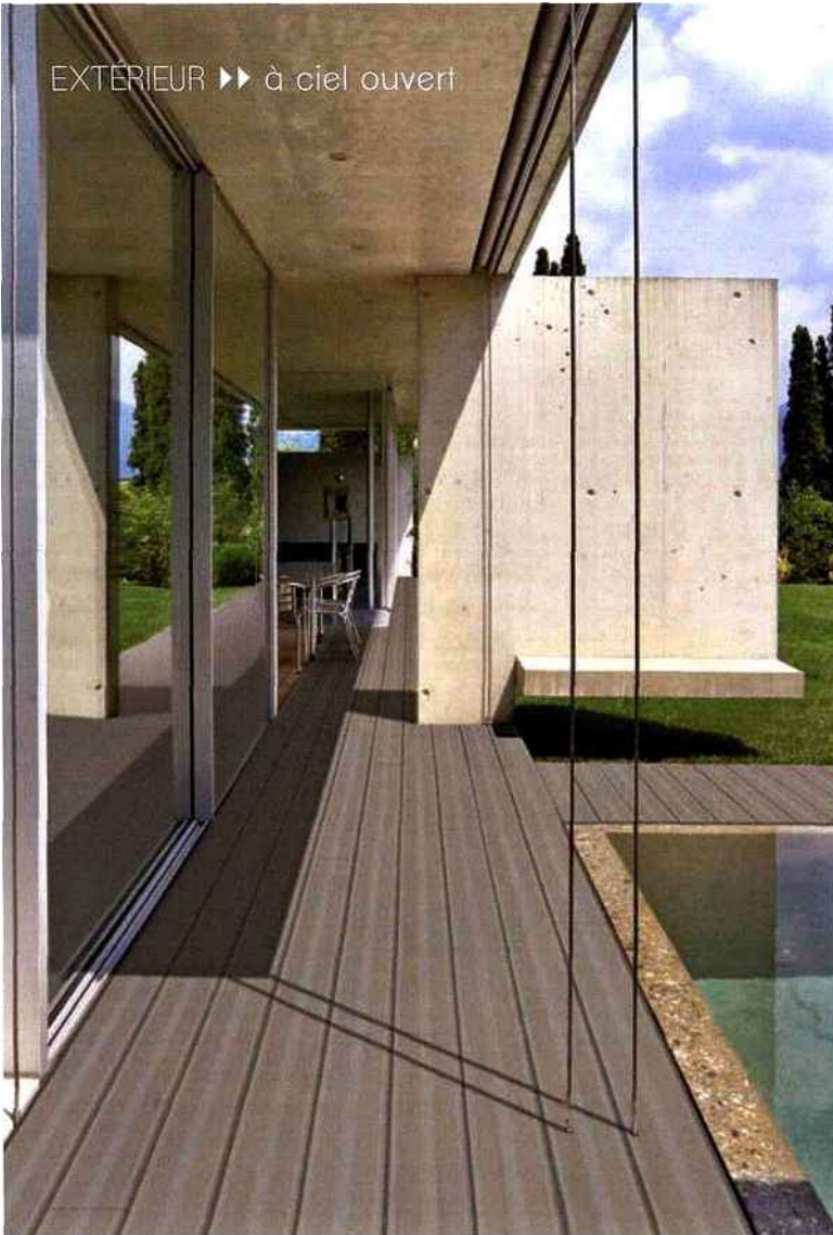
Coursive en pin radiata satire, classe 4 autoclave, color Armor Grey ©Protac Ouest
