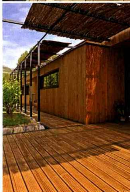
Terrasse rénovée avec un calaminage de dalles en ipé, ainsi que la banquette et le claustra sur-mesure. Réalisation Exonido (Lyon 2ème)
